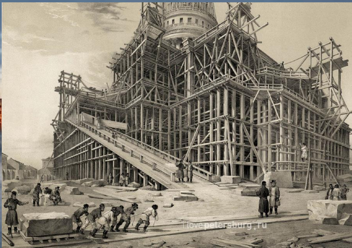
Строительство Исаакиевского собора
